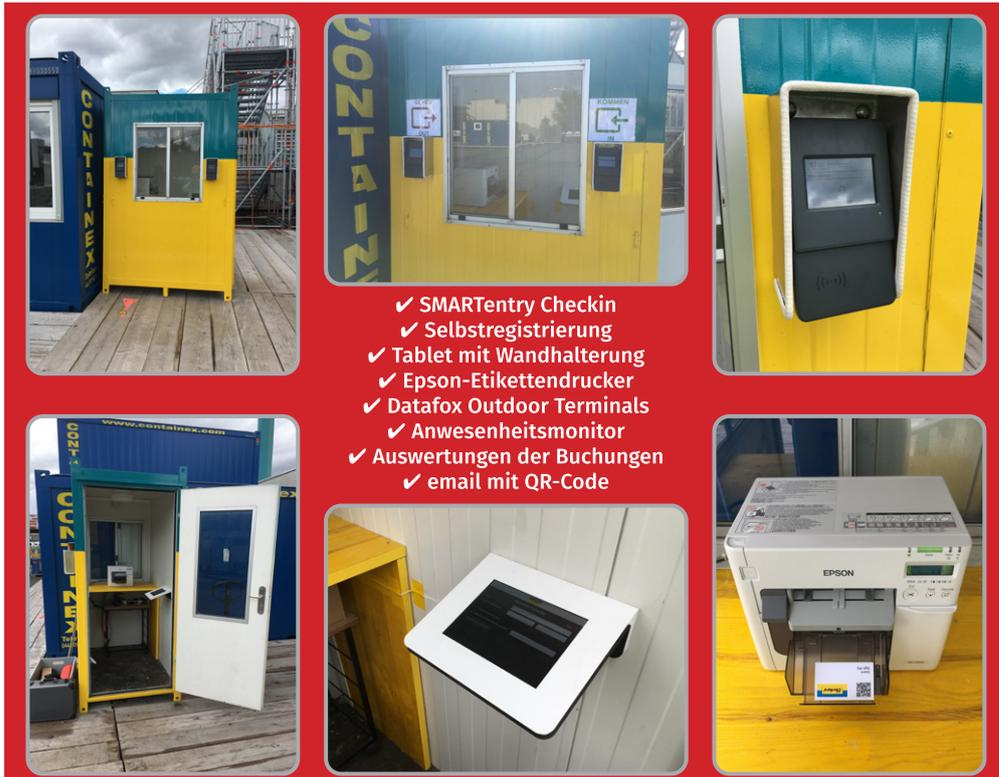
reibungslosen Check-In zu gewährleisten. Mit der Softwarelösung **SMARTentry** können sich Baustellenmitarbeiter und Besucher eigenständig an einem Terminal registrieren. Danach können sie sich an den außen angebrachten Check-In und Check-Out Datafox Terminals an einem Container mit einem QR Code anmelden.
